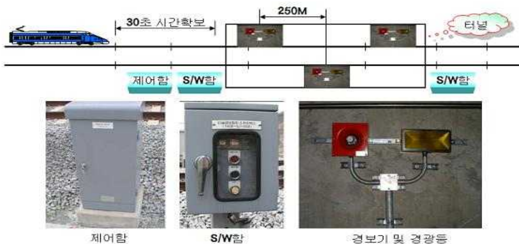
그림 11. 터널정보장치 시스템 계통도
